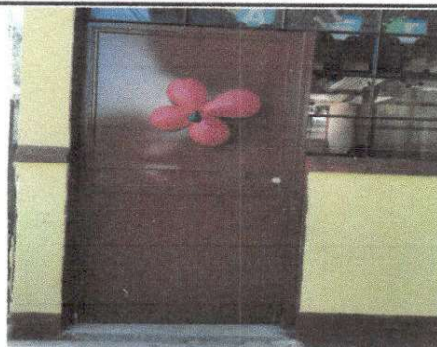
Foto 6: Sustitución de puerta de metal.
