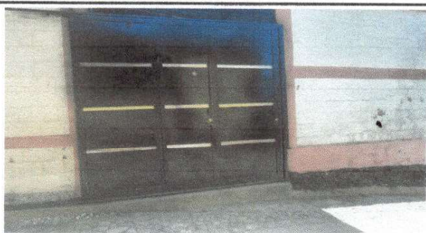
Foto 5: Sustitución de porton de metal.
