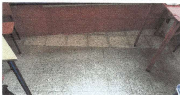
Foto 4: Sustitución de piso de granito.
