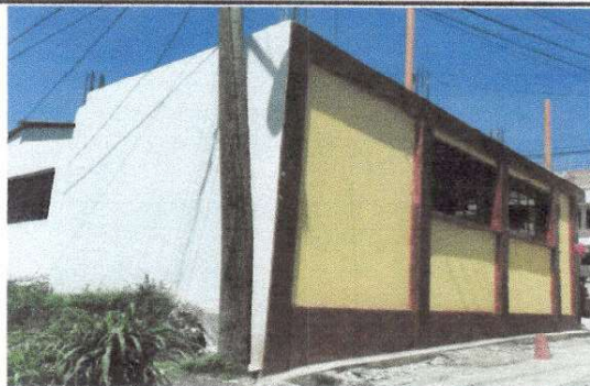
Foto 2: Sustitución de lamina por block en pared.
