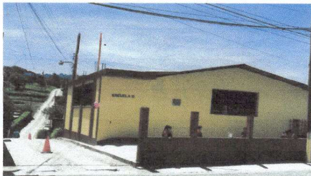
Foto1: Sustitución de lamina por block en pared.
